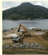
九島架橋工事現場
